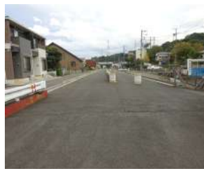
穴部地区の整備済み区間
