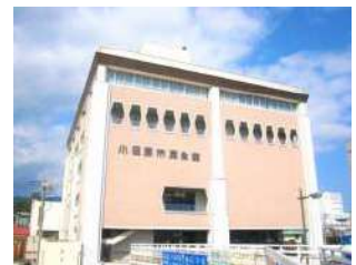
解体される旧小田原市民会館
